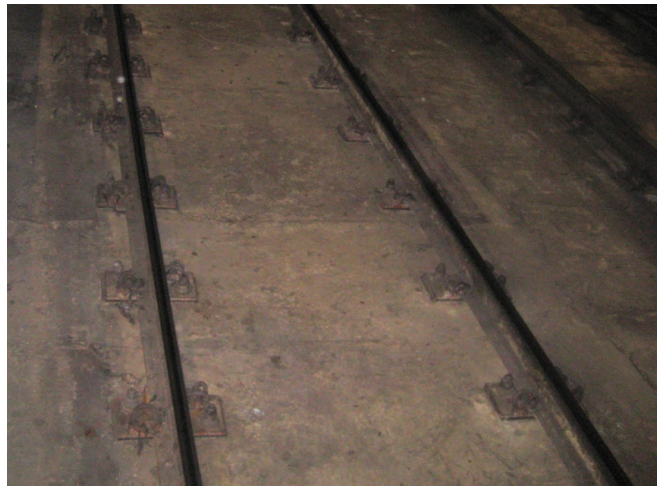
Fig. 2. Vía sobre placa con fijaciones DFF. Línea 3 del Ferrocarril Metropolitano de Barcelona.
